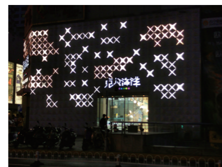
8. 某商场外墙装饰中的“×”元素 (作者摄)
